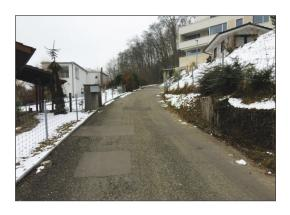
Die Zustandsuntersuchung des Belages und der Fundationsschicht hat ergeben, dass der bestehende Strassenoberbau den heutigen Ansprüchen nicht entspricht und erneuert werden muss. Die bestehende Fundation weist eine ungenügende Mächtigkeit auf und muss durch eine neue, aus frostsicherem und tragfähigem Material ersetzt werden. Die Randabschlüsse werden auf der ganzen Länge beidseitig der Strasse angepasst, respektive ersetzt. Der Knoten Sandstrasse/Staldenstrasse wird ent-
